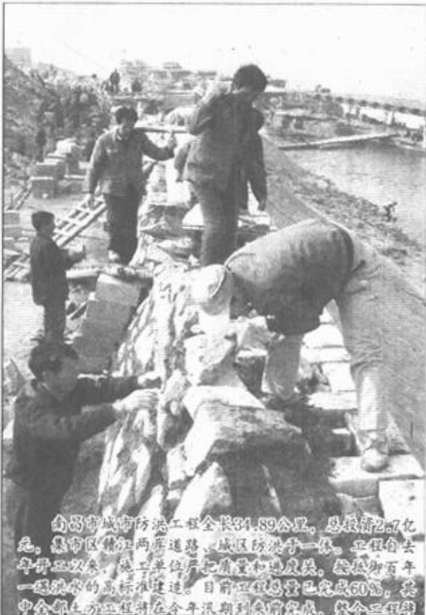
▲于今年10月1日竣工。图为滨江路新州闸至新八一大桥一段路堤的建设场景。（新华社记者 宋振平 摄）
